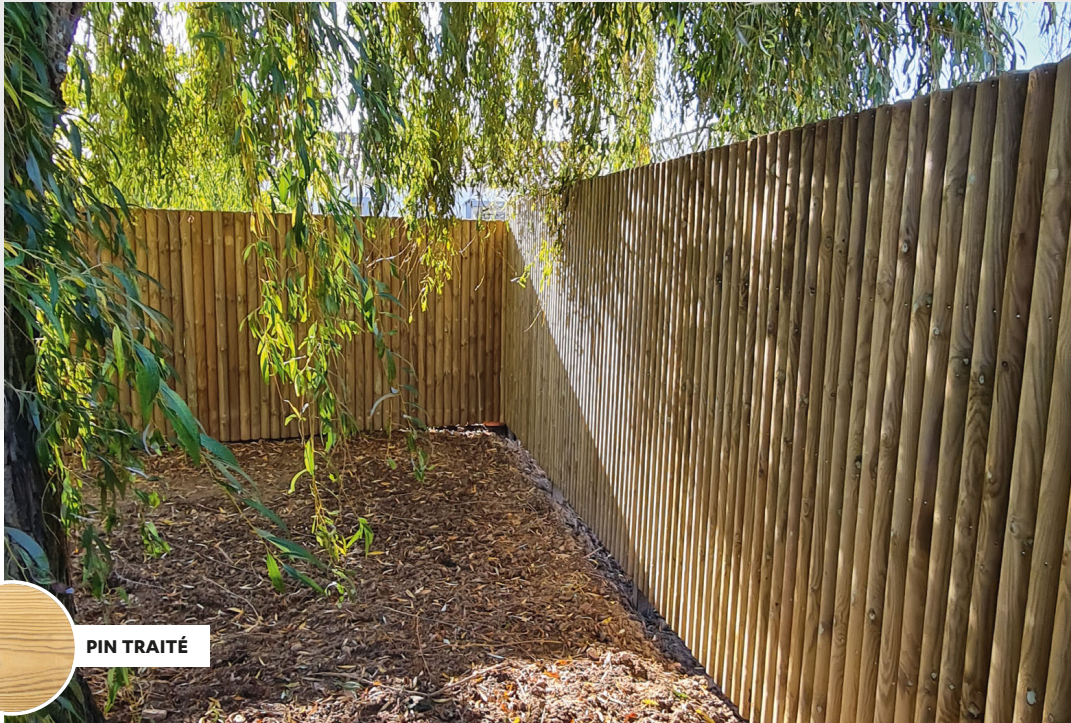
Clôture sur-mesure en pin traité habillée sur les deux faces de demi-rondins Ø 80 mm, poteaux en pin Classe 4 invisibles
